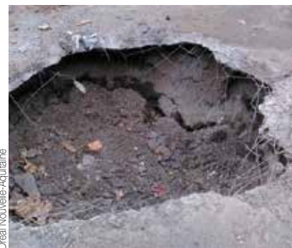
◀ Cratère provoqué par l'explosion d'une munition dans une installation de traitement de déchets.
